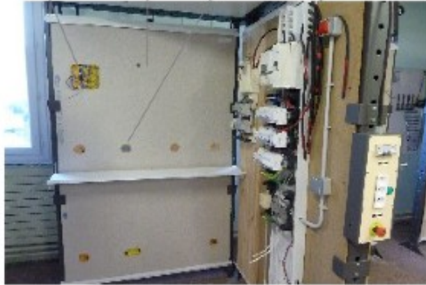
Figure 5 : poste de travail de l'élève de 2e bac pro ELEEC.
