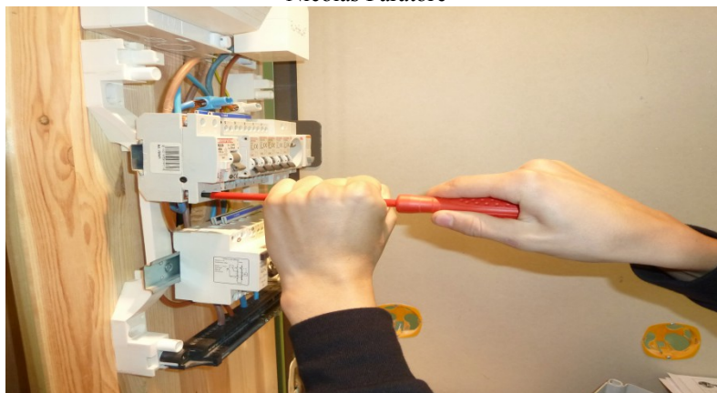
Figure 3 : usage d'un tournevis avec isolant par un sujet droitier pour visser les conducteurs électriques phase et neutre sur le disjoncteur différentiel 30 mA
